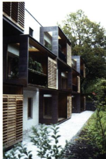
▲ Côté cour, des loggias prolongent les espaces de vie
