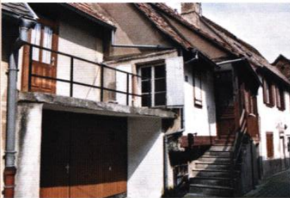
▲ la terrasse, le garage et un auvent d'entrée ont été difficilement gagnés sur l'emprise de la cour privée, afin de donner des prolongements extérieurs au logement.
