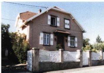
▲ Villa, rue Clemenceau
