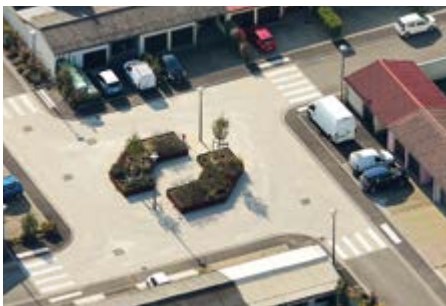
Travaux de voirie et d'éclairage public : 1 605 300 €
