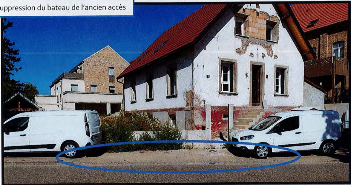
Création d'un bateau pour le nouvel accès
