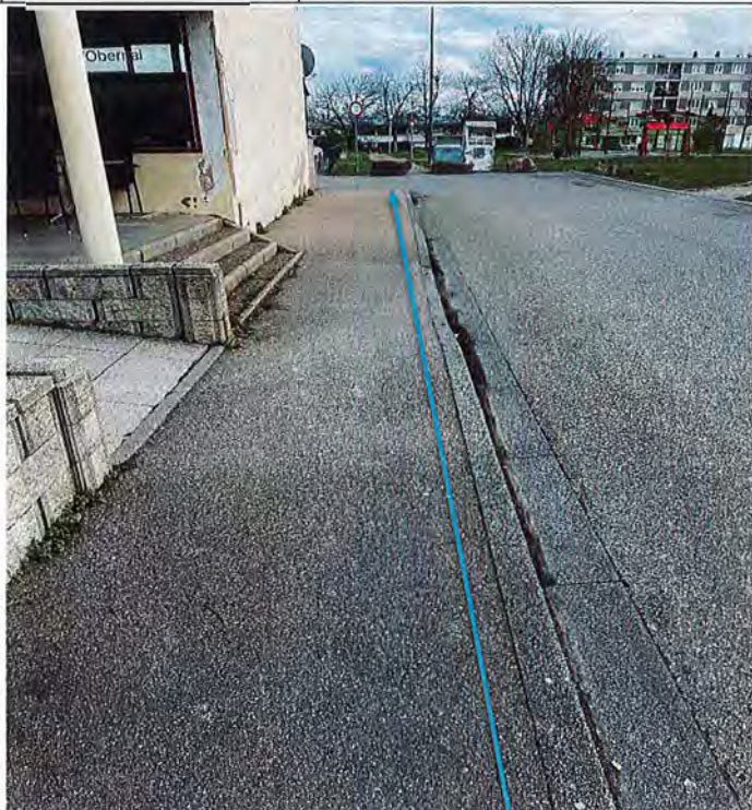
POSE DE 3 PEHD Ø40 Tranchée traditionnelle sur trottoir + chaussée ( 6 ml ) Remblai avec extraît - Réfection en ENROBE
