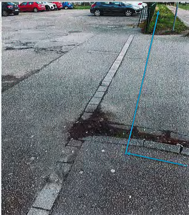
POSE DE 3 PEHD Ø40 Tranchée traditionnelle sur trottoir + chaussée ( 6 ml ) Remblai avec extraît - Réfection en ENROBE
