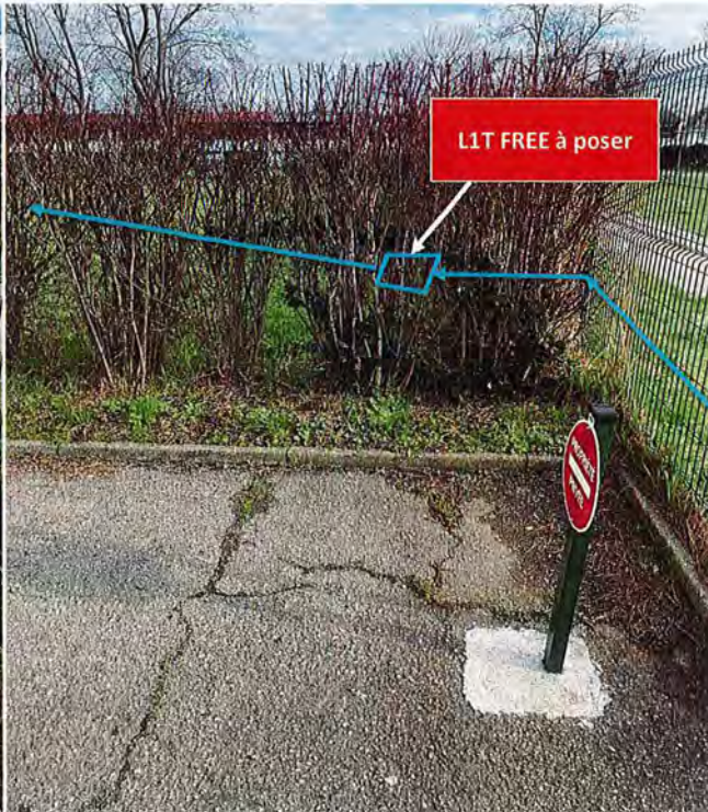
POSE DE 3 PEHD Ø40 + 1 L1T FREE Tranchée traditionnelle sur terrain naturel Remblai avec extraît - Réfection en ENROBE
