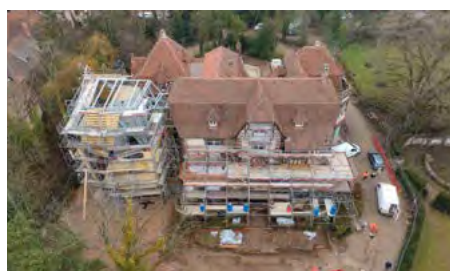
Suite des travaux de restauration du Domaine de la Léonardsau
