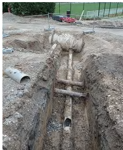
Renouvellement branchement en amiante
